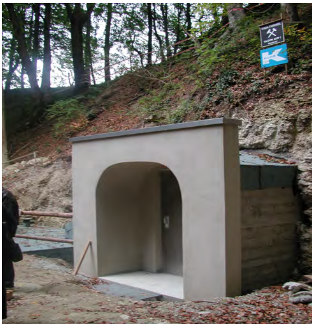
Вход на водохващане на извор Фото източник: Bayerisches Landesamt für Umwelt (Службата по околна среда на провинция Бавария); ( http://www.lfu.bayern.de/wasser/merkblattsammlung/teil2_gewaesserkundlicher_dienst/doc/nr_219_anlage6.pdf )
