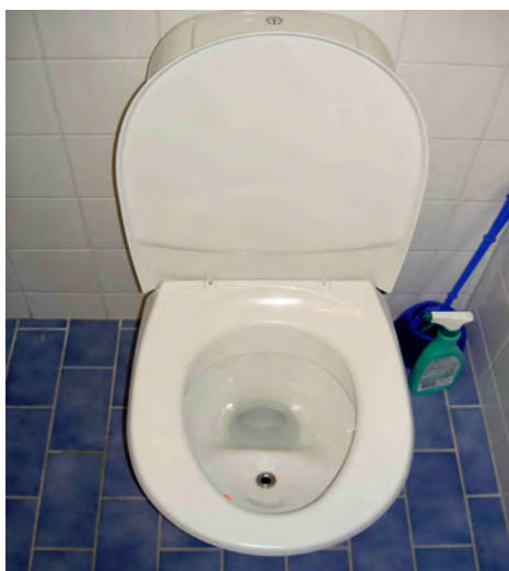
Разделителна тоалетна с изплакване с вода
