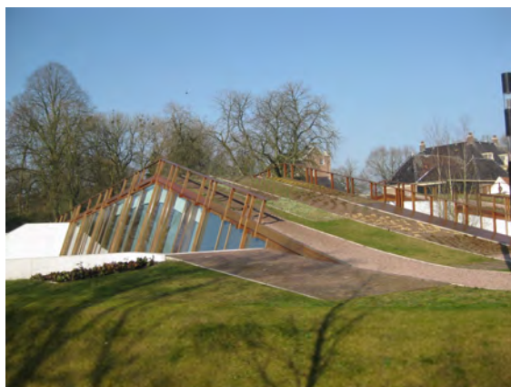
Пример за екстензивен зелен покрив на обществена сграда
