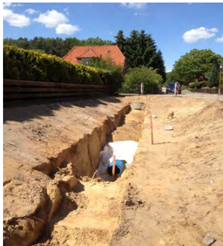
Система за проникване на води тип Rigole в процес на строеж
