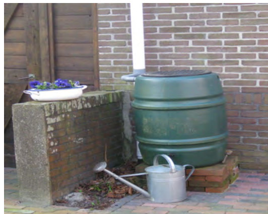
Различни типове резервоари за съхранение на дъждовни води за употреба от домакинствата
