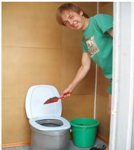
“Изплакване” на тоалетната след използване при суха тоалетна с разделяне на урината в Украйна
