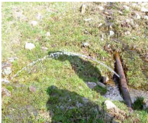
Корозија може да предизвика сериозни истекување во дистрибутивниот систем
