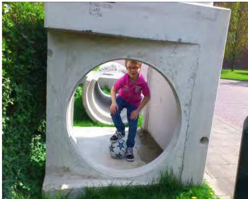
Цевка за собирање отпадни води со дупка за човечки пристап која ќе биде поставена под земја
