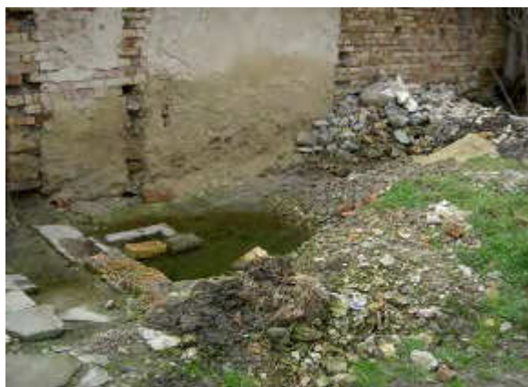
Апсорбирачка јама полна со отпадни води
