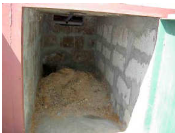
Училишен СТПУ: комора за собирање, складирање и третман на фекални материи
