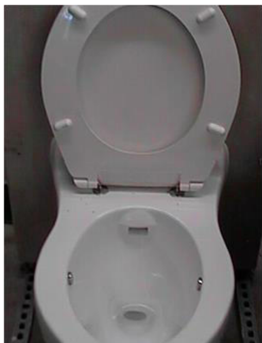
Вакуумный туалет, использующий один литр за смыв
