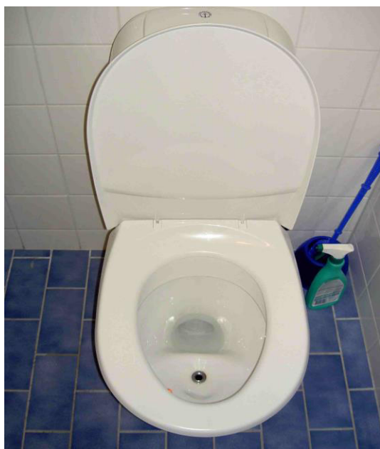
Туалеты с отведением мочи со смывом
