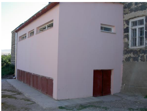
Exteriorul unei instalații UDDT anexată unei școli
