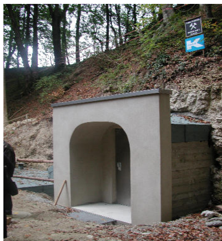
Вход в обустроенное место водозабора (родник)
