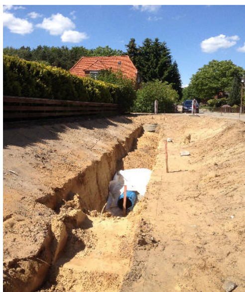
Процесс конструкции траншейной инфильтрационной системы Фотография: Арнд Вендланд
