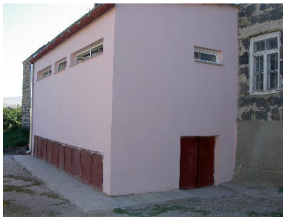
Внешний вид туалета Экосан, пристроенного к зданию школы
