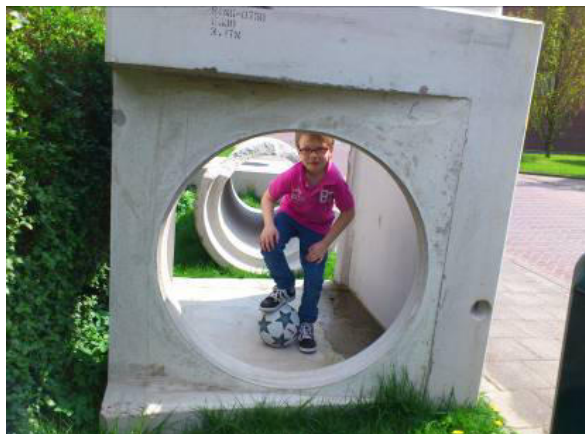
Подземная труба для сбора сточных вод с отверстием для люка
