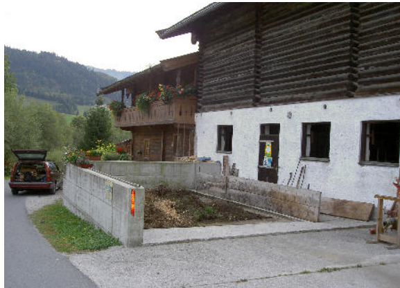
Навоз должен храниться на огороженной бетонированной площадке.
