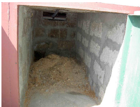
Школьный Экосан туалет: камера для сбора, хранения и обработки фекальных масс
