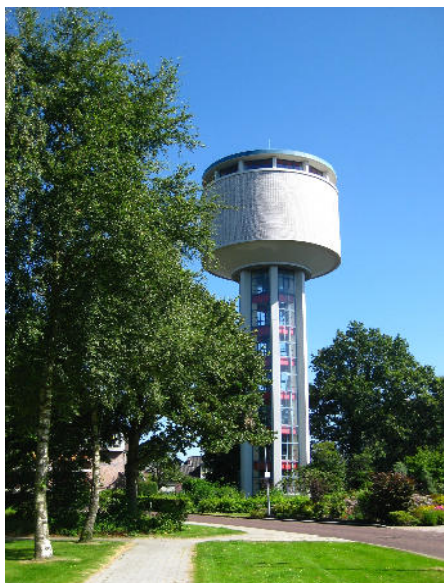
Водонапорная башня регулирует давление подачи воды днем и ночью
