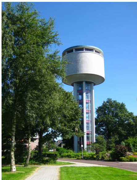
Un turn de apă ce menține o presiune corespunzătoare ziua și noaptea
