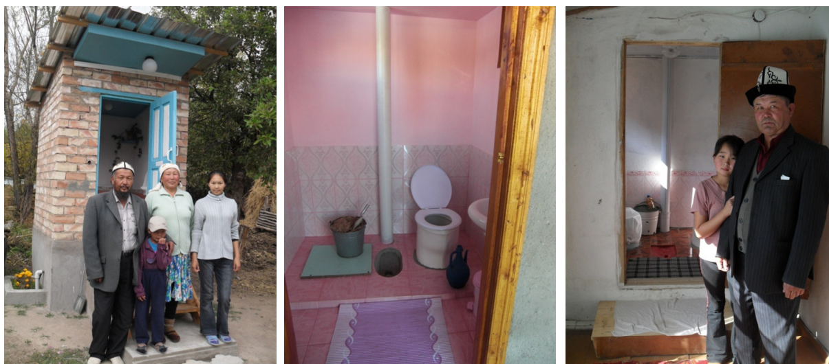
Ecosan (UDDT) toilets outdoor and indoor
