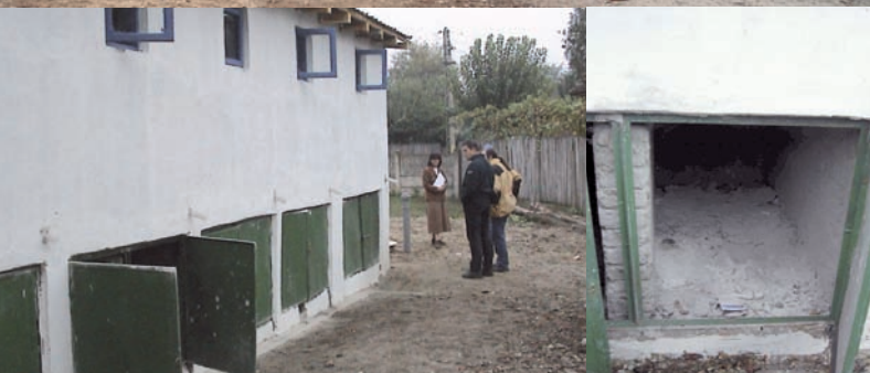
Вид нового туалета сзади, с открытыми дверьми на фекальное помещение с двумя камерами
