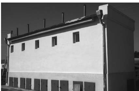
Сухой туалет с отведением урины с пассивной вентиляцией
