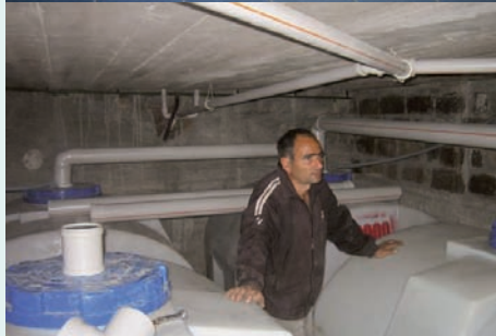
Обслуживающий персонал в туалете, где установлены четыре резервуара для сбора урины (каждый размером 2 м 3 ) (фото AWHHE)
