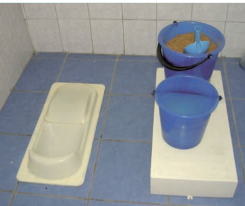
Вид туалетной комнаты с установкой китайского сиденья на корточках
