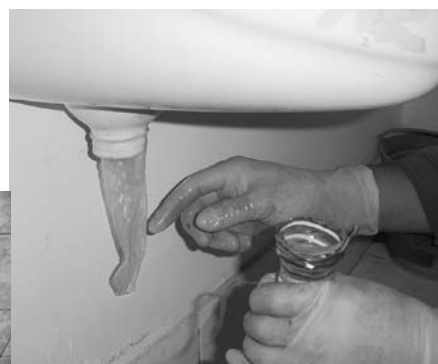
Установка уловителя запаха в трубе для стока урины под безводным писсуаром
