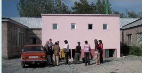
Вид новой туалетной комнаты
