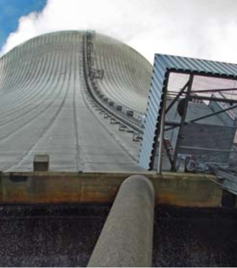
Die Kühlung ist ein elementarer Bestandteil der Sicherheitstechnik bei Kernkraftwerken. Bildquelle: Kurt Michel, www.pixelio.de
