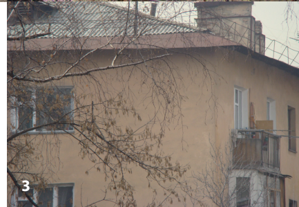
Рис.3 Крыша жилого дома покрыта шифером из асбеста
