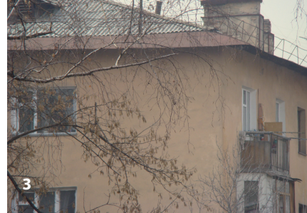
3 – сурет. Тұрғын үйдің шатыры асбестен жасалған шифермен жабылған
